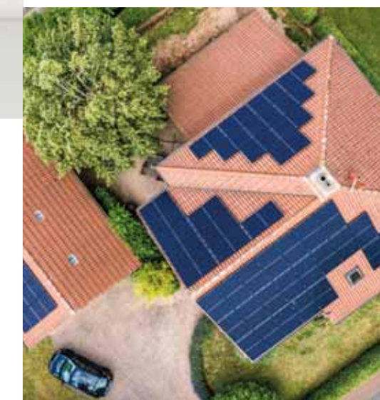
Preiswerter „Kraftstoff“: Der gewonnene Solarstrom wandert in den Stromspeicher und steht dann auch für das E-Fahrzeug zur Verfügung.
