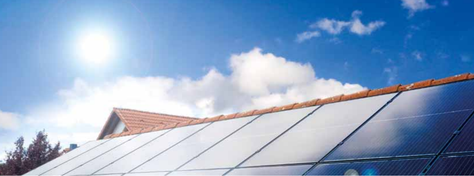
Die Photovoltaikanlage ist das Herzstück und Grundvoraussetzung des nachhaltigen Modernisierungskonzepts.
